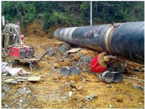
图21 基于AVR单片机研制焊机在施工现场
